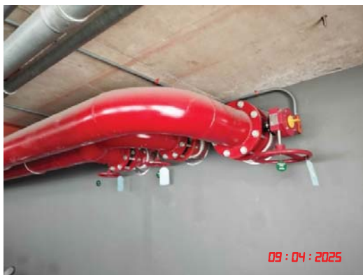
ระบบท่อจ่ายน้ำดับเพลิง
